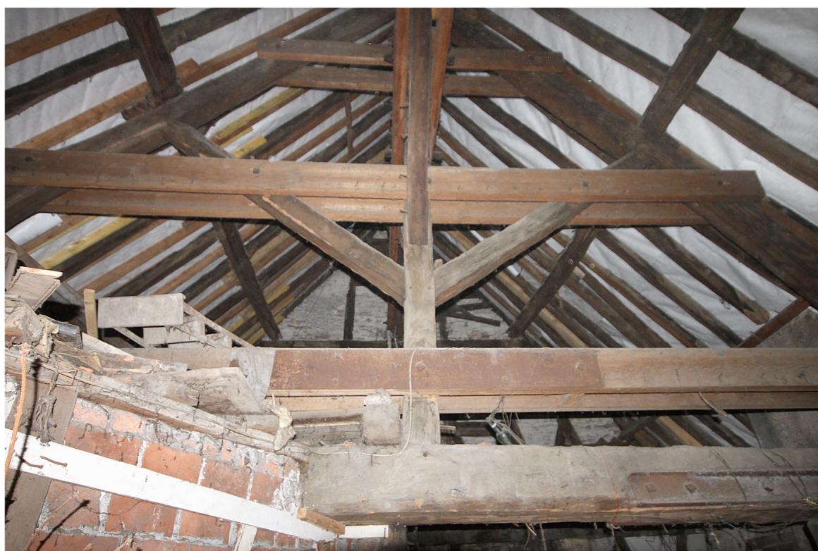
Fig. 6 : Charpente à pannes composée de 3 fermes, marquées de I à III sur les faces Nord des pièces (poinçons, arbalétriers, entrails, contrefiches).
